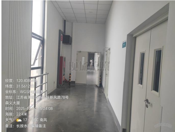
生产车间二层现状(暗室、评片室现状)
