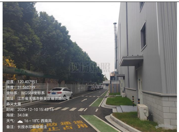
厂内生产车间西侧现状
