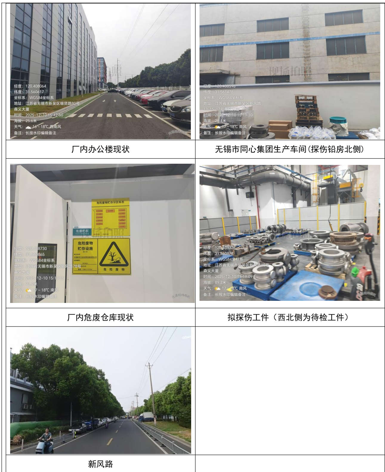
图 8-1 探伤铅房、暗室、评片室、危废仓库及其周围现状图
