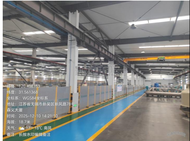
生产车间二层现状
