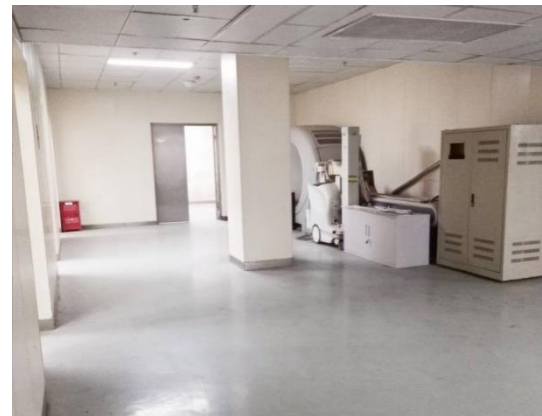
图 8-4 拟改建的医用直线加速器机房西侧(通道、模具间)
