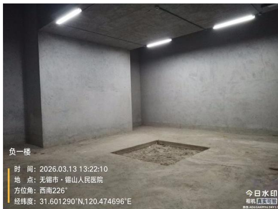
图 8-1 拟改建的医用直线加速器机房
