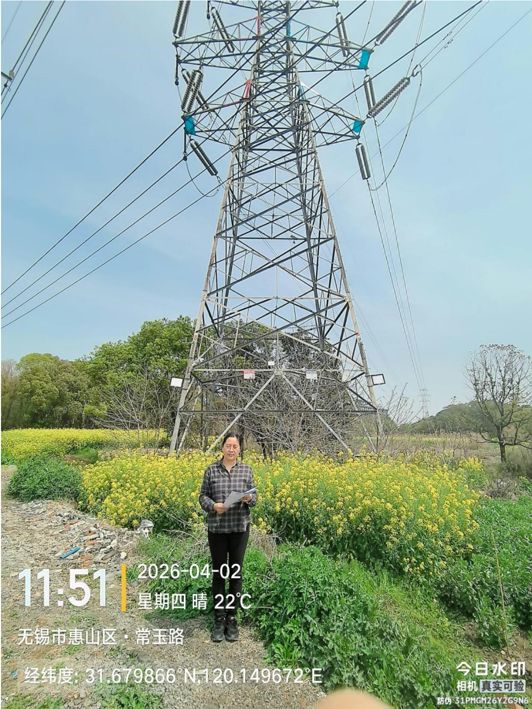
拍照地点：220kV 惠前 2X37/2X38 线 33#塔
