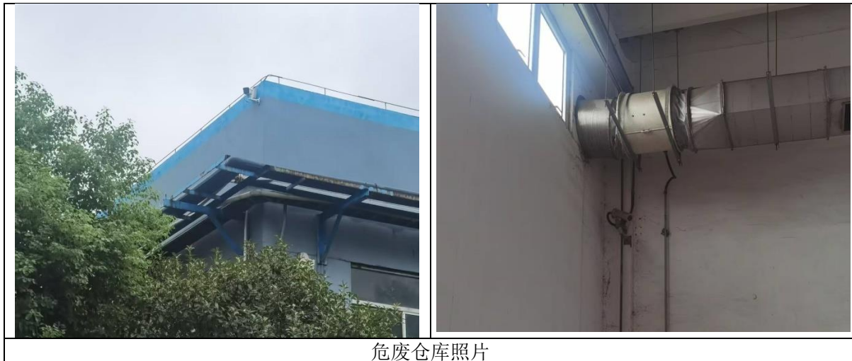
图 3.3.8-1 危废仓库现场情况
