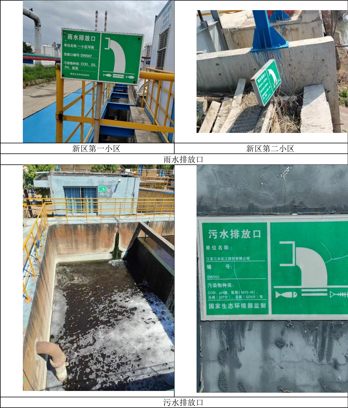
图 3.3-5 现有雨水及污水排放口现场情况
