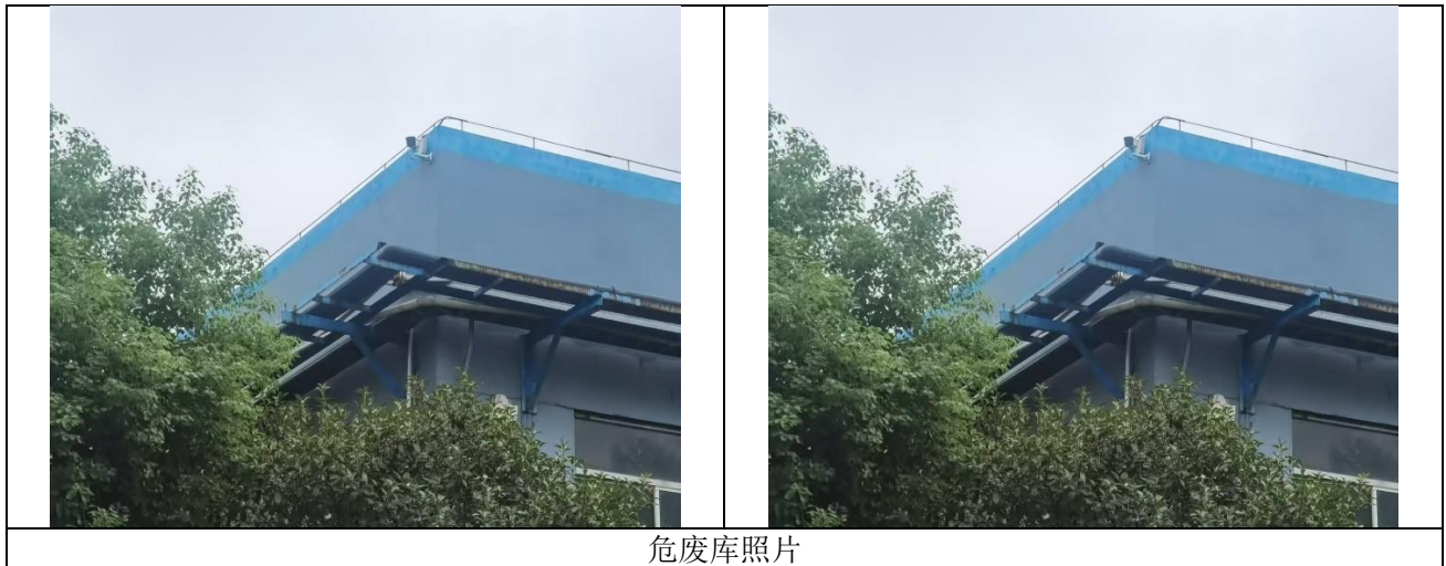
图 3.3-3 危废暂存库现场情况
