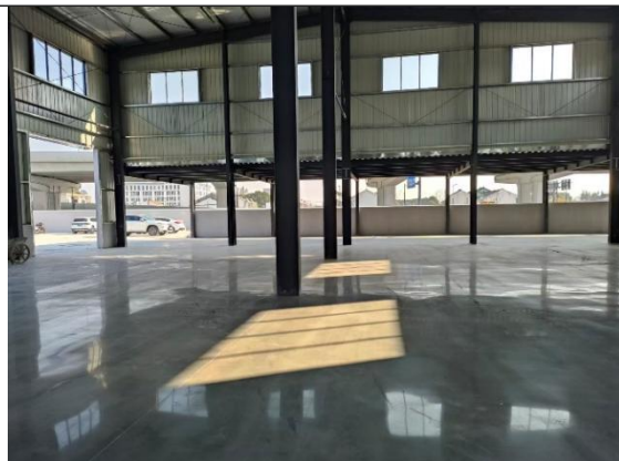
本项目电子加速器辐照装置拟建址东侧 (车间内部场所)
