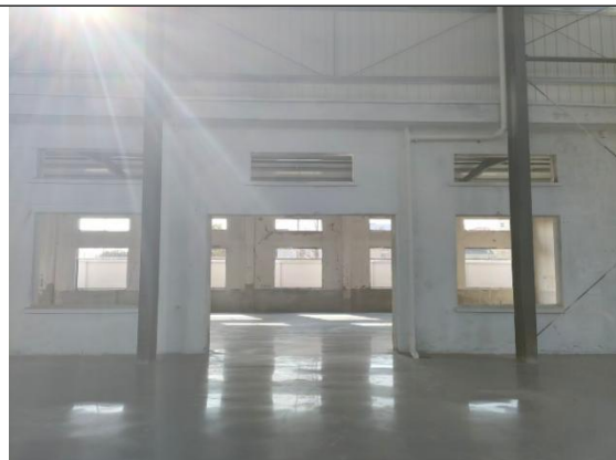
本项目电子加速器辐照装置拟建址南侧 (下料区)
