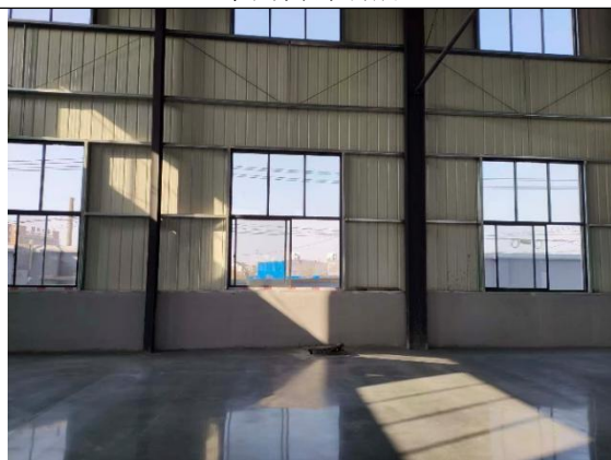
本项目电子加速器辐照装置拟建址西侧 (车间内部场所)
