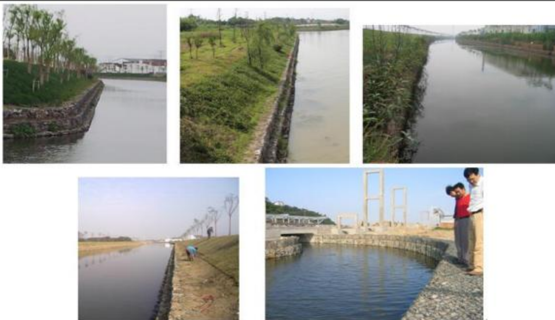
图 2-13 生态网箱断面河道实景照片
