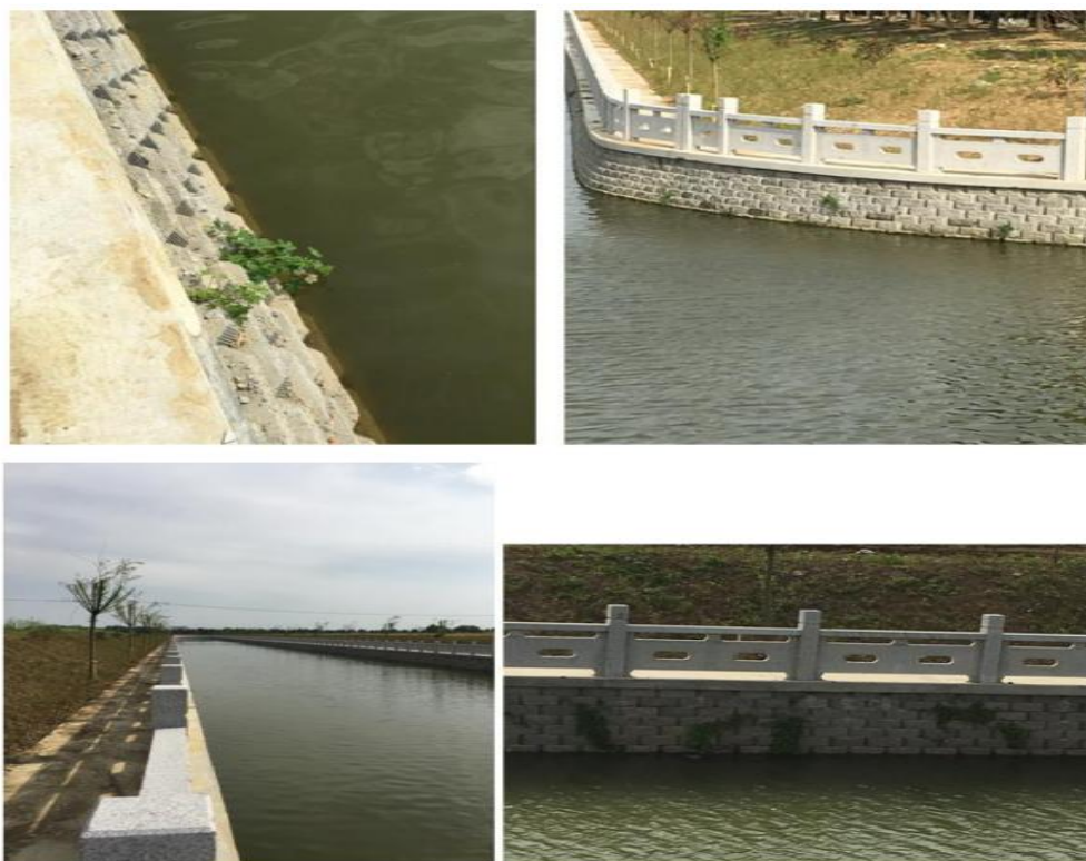
图 2-11 浆砌石护岸实景照片
