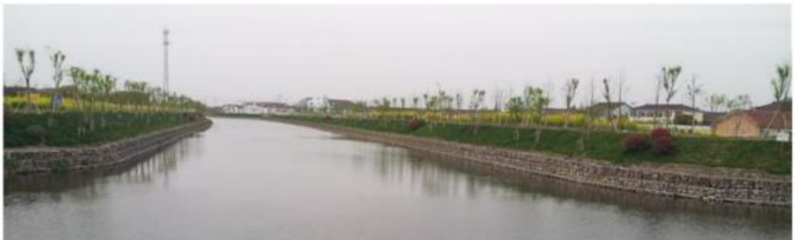
图 2-12 生态砌块护岸实景照片
