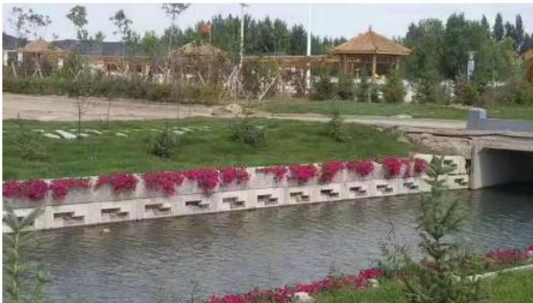
图 2-14 生态网箱断面河道实景照片
