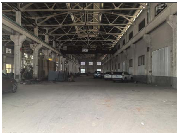
探伤房南侧无锡华精新材股份有限公司生产车间
