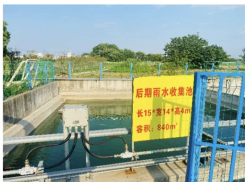
后期雨水收集池
