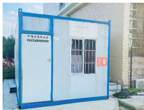
污水在线监测系统
