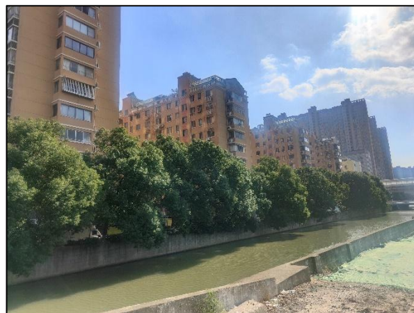
图 4.2-2 项目沿河岸现状照片
