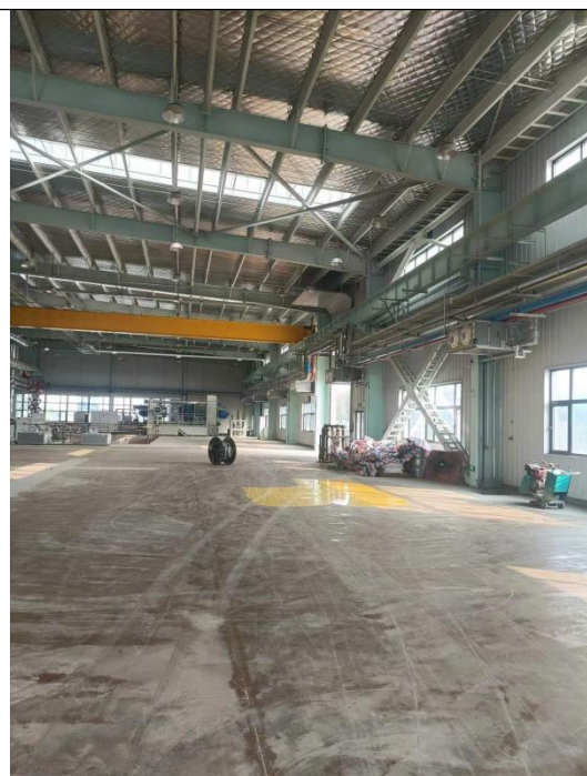
X射线检测室拟建址东侧
