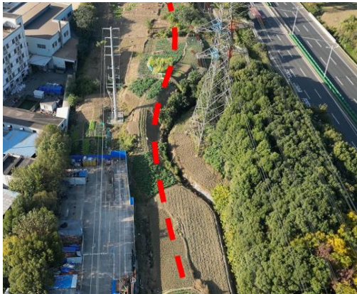
拟设置输水管道处现状
