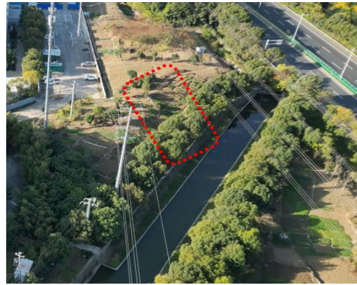
拟安装活水泵站处现状
