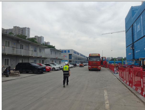
医疗综合楼东侧院内道路
