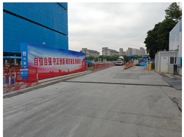
医疗综合楼北侧院内道路
