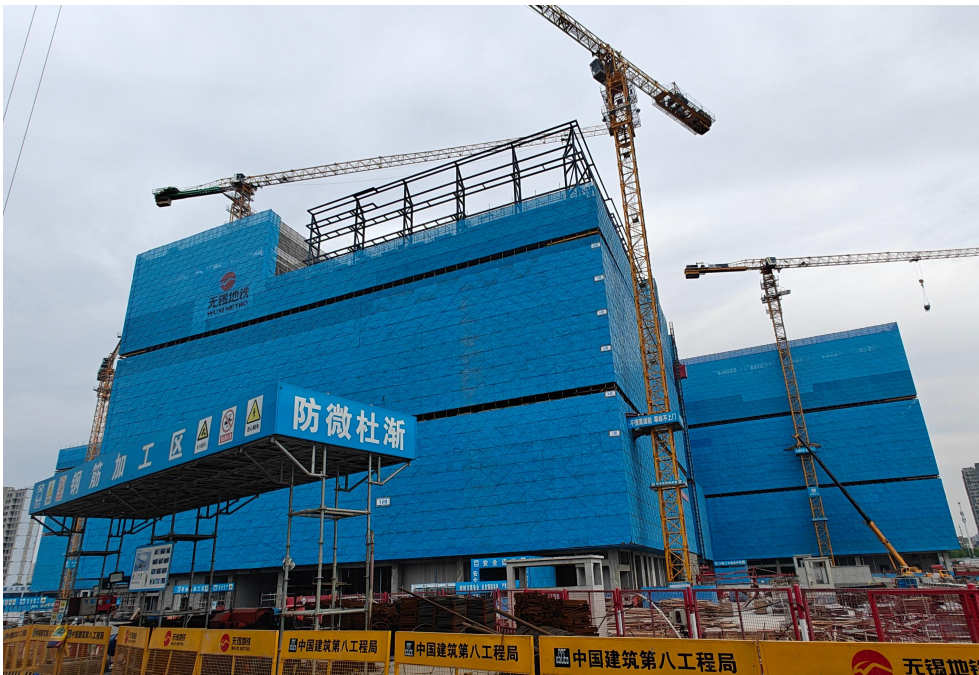
本项目所在医疗综合楼
