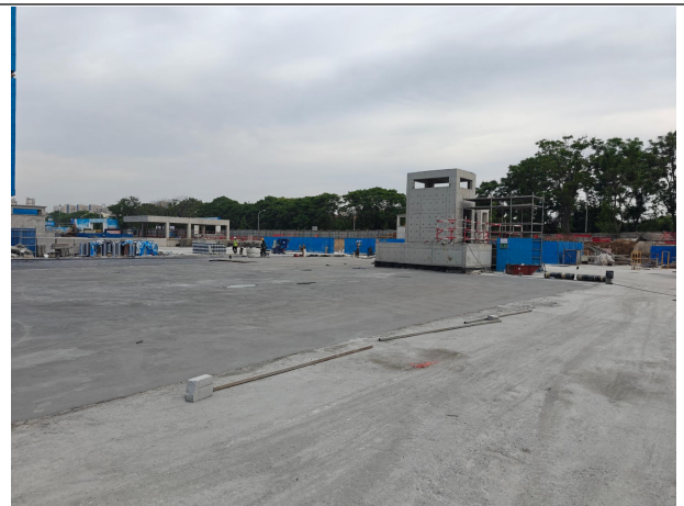
医疗综合楼南侧院内道路
