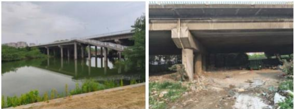
图 3-7 东亭路高架桥现状图
