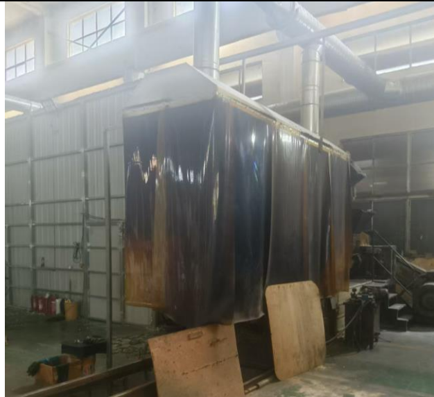
图 4-1 挤出机废气收集设施照片
