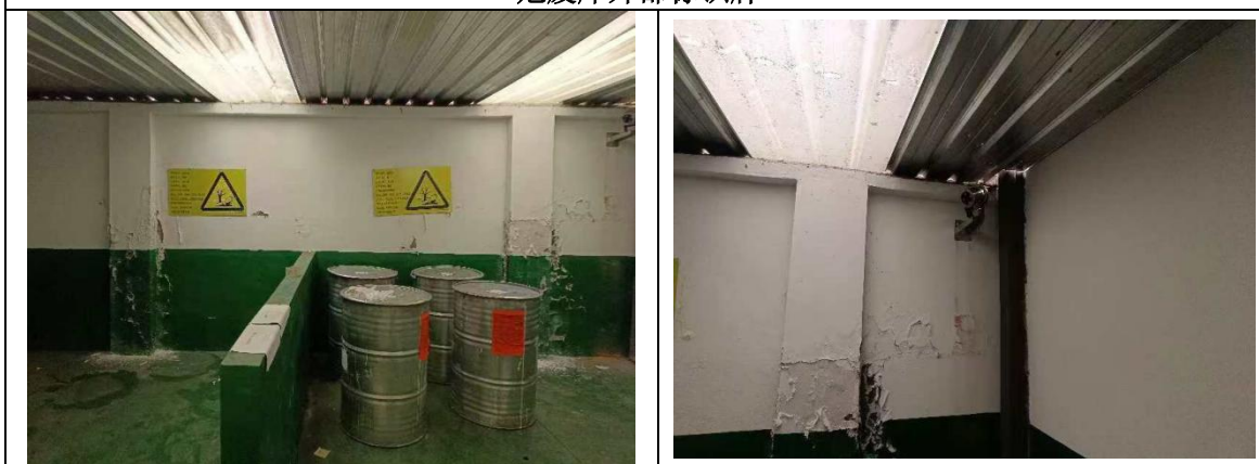
危废库内部分区及标识牌
